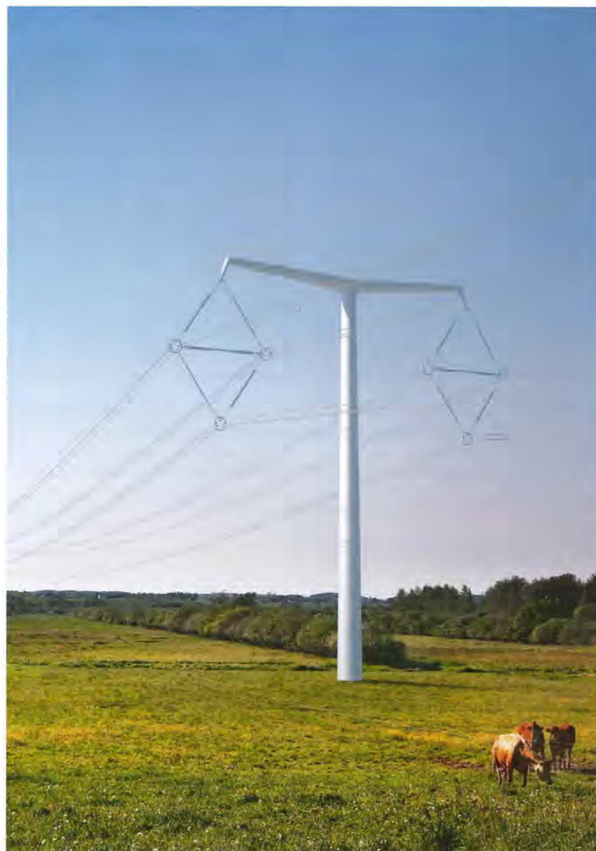
Nybyggd dubbel 400 kV ledning i England designad av arkitektföretaget Bystrup i Danmark. Foto: Bystrup.
